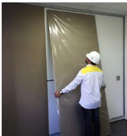
**2.** Deslizar o painel até encaixar no perfil metálico "J" inferior.
