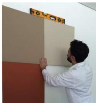
**3.** Usar espaçador para padronizar os espaços e fixar os painéis na superfície. Aguardar 20 minutos para os ajustes e/ou remoção dos painéis.
