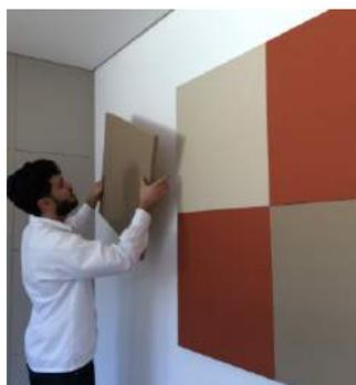
**4.** Atentar-se para o correto alinhamento da superfície, pressionar os quatro pontos contra a parede para uma fixação firme e uniforme.
