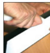
4 - Esfregar a fita para aderência. Pode ser utilizado um estregador de nylon ou de madeira envernizada para não danificar a fita.
