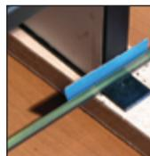
5 - Para destopar o excesso da fita utilizar uma serra de ferro.
