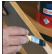
1 - Aplicar uma camada de cola de contato no substrato. Aguardar secagem total da primeira camada e aplicar segunda demão de cola. Todas as camadas de cola devem ser bem distribuídas e finas.
