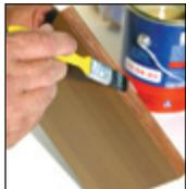
1 - Aplicar uma camada de cola de contato no substrato. Aguardar secagem total da primeira camada e aplicar segunda demão de cola. Todas as camadas de cola devem ser bem distribuídas e finas.
